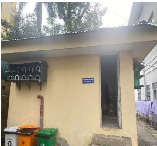
Trạm bơm nước sạch
