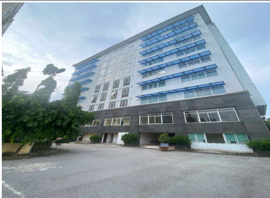
Khu nhà làm việc 9 tầng của cơ sở
