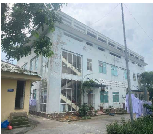
Khu nhà làm việc 2 tầng của cơ sở
