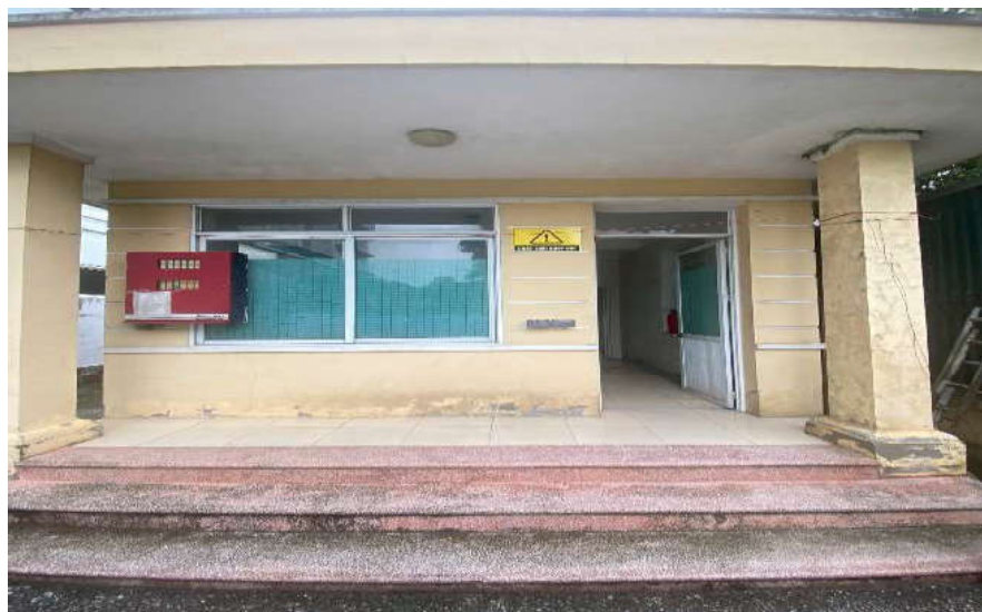
Hình 3-15. Kho lưu giữ chất thải nguy hại tại Cơ sở
