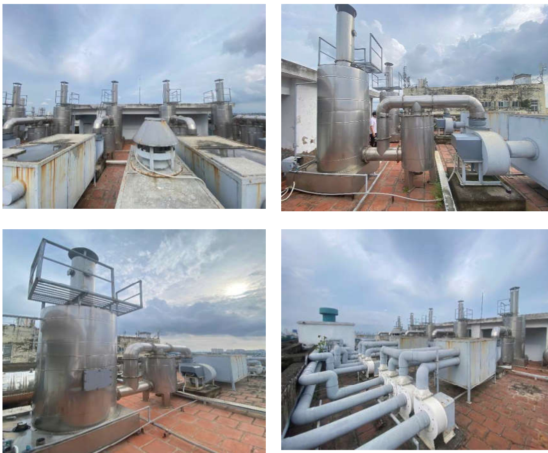
Hình 3-13. Hệ thống xử lý khí thải của cơ sở
