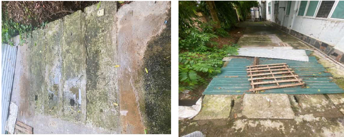
Hình 3-8. Hệ thống bể xử lý vi sinh và khử trùng (bể 05 ngăn)
