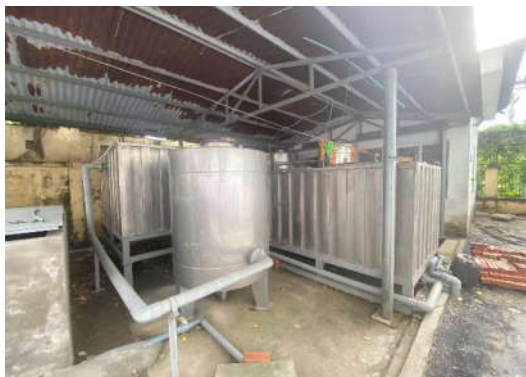
Hệ thống xử lý nước thải PTN
